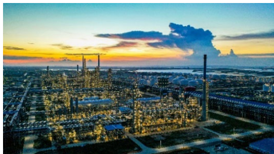
镇海基地项目
