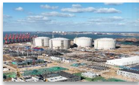
龙口LNG项目
