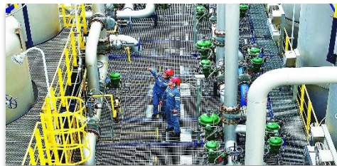
天津石化高性能聚乙烯项目
