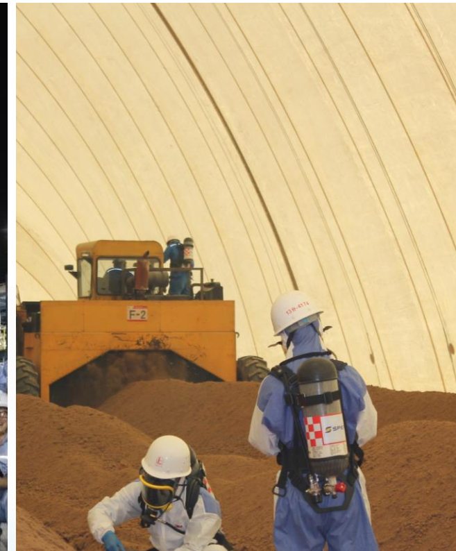
拆除-修复-利用
